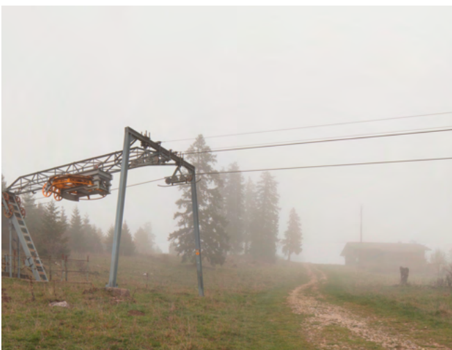
Bald werden sie abgerissen: einer der todgeweihten Skilifte der Tête de Ran. (Foto: Olivier Rügsegger, ©Alpines Museum der Schweiz)
