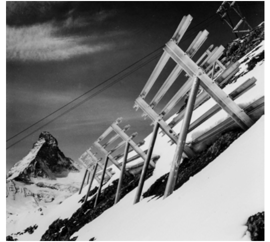
Lawinerverbauungen in Zermatt/Schweifinen, 1957. ©Perren-Berberini Zermatt
