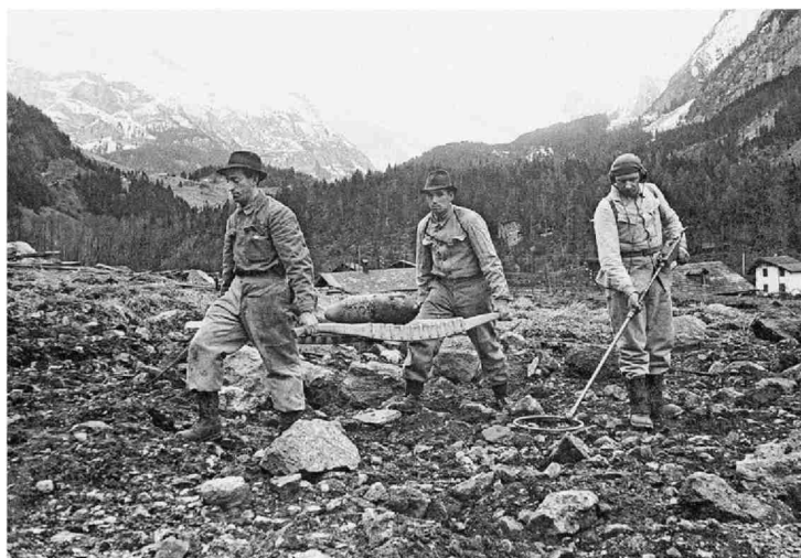
Aufräumarbeiten nach der Katastrophe von Mitholz 1947. Foto: zvg
